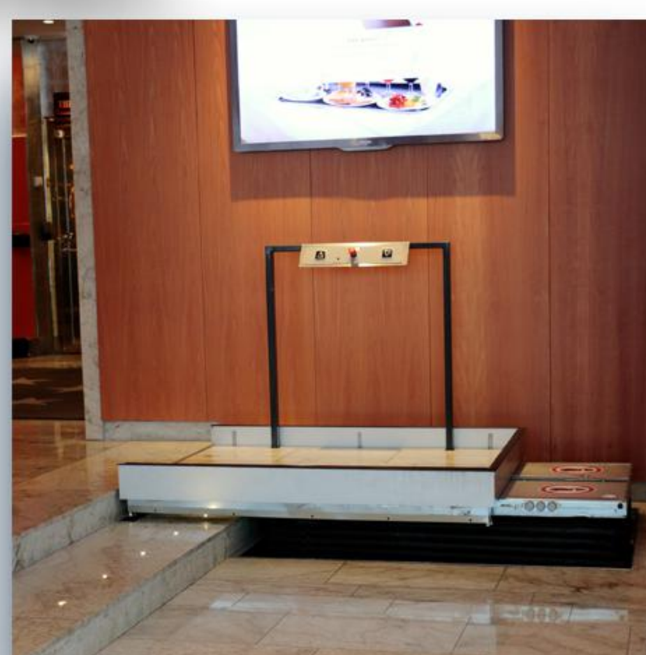
LP50H Hebeplattform Hubhöhe bis 830mm und bis zu 900 mm horizontal
